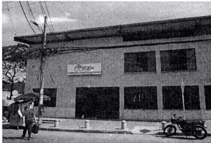
Aspecto de la fachada del Instituto, se observa la cubierta
