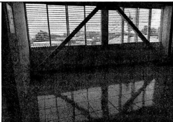
CONSTRUCCION DE DOS AMBIENTES DE APRENDIZAJE:
